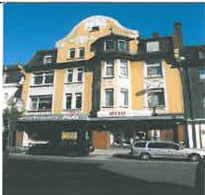
44287 Dortmund- Aplerbeck Objekt Nr. 2100
